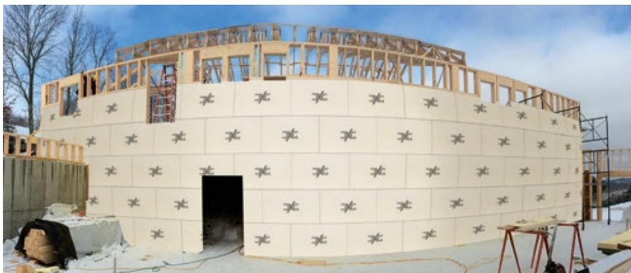
*Lastra fibrorinforzata ad alte prestazioni caratterizzata da un'alta resistenza all'umidità ed all'acqua. Particolarmente indicata per la realizzazione di rivestimenti esterni, pareti perimetrali anche con rivestimento a cappotto, controsoffitti in piani pilotis, ove si richieda una elevata impermeabilità.*
